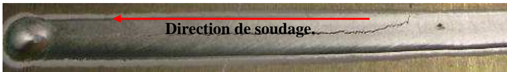
Fig. 4 : Fissuration obtenu en soudage à l'arc.
