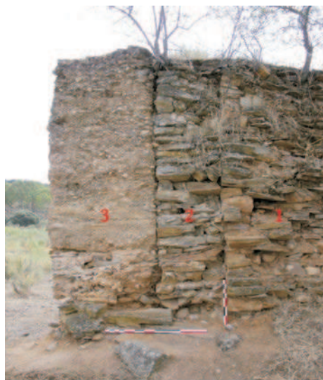
Figura 6. Detalle de una torre del lienzo sur con identificación de tres fases constructivas.
