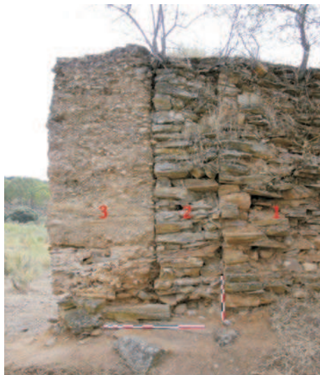
Figura 6. Detalle de una torre del lienzo sur con identificación de tres fases constructivas.
