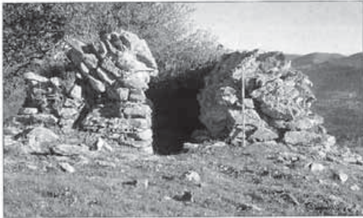
Lámina 1. Vista frontal del aljibe I.
