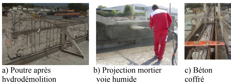
Figure 2. Phases de préparation et réparation par les techniques sélectionnées.
