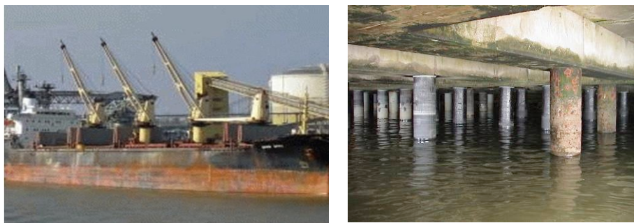
a) Vue générale
