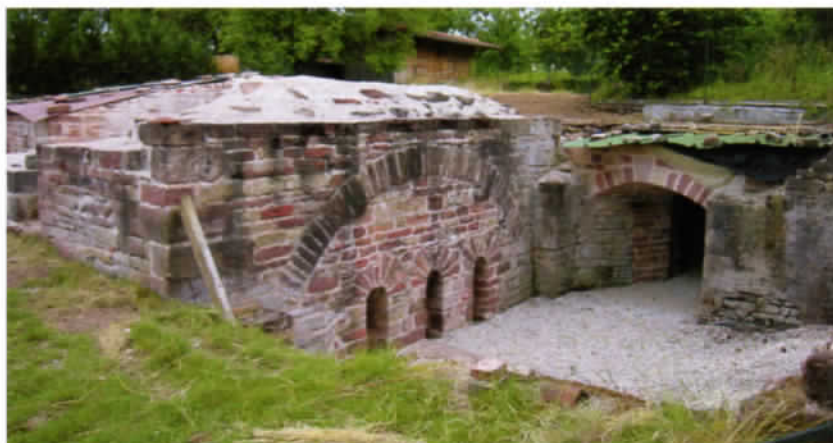
Vue du site après la fouille. Au premier plan de gauche à droite, le four Fr01 et l'entrée du four à chaux Fr03 après restauration.
