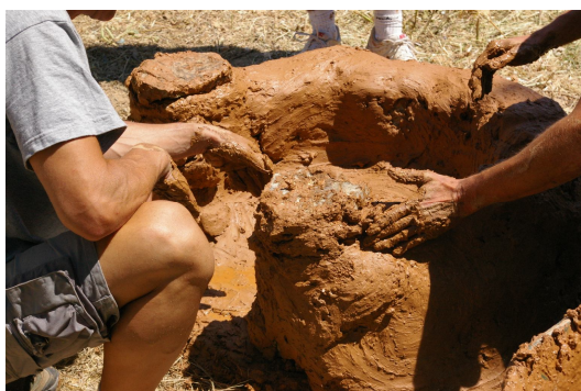
Fig. 22 – Bas fourneau de réduction (Fe) en construction. Installation de la base du four. Bargemon (Var) Expérimentation archéologique 2012. (Photographie : D. Morin).
