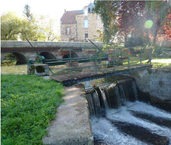
Clapet basculant (à gauche) et crémaillère (à droite)
