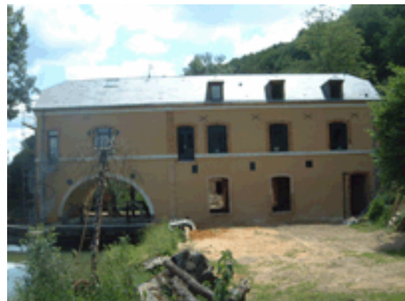
Etat du moulin de Chérré après les travaux
