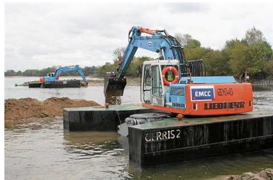
Les barges flottantes utilisées lors de l'opération de remodelage (Ouest-France, 12/10/09).
