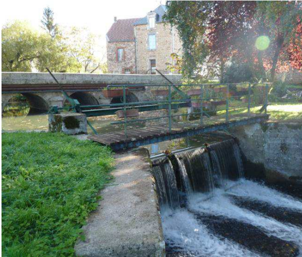
Clapet basculant en amont du moulin de Saugères à Sainte-Suzanne
