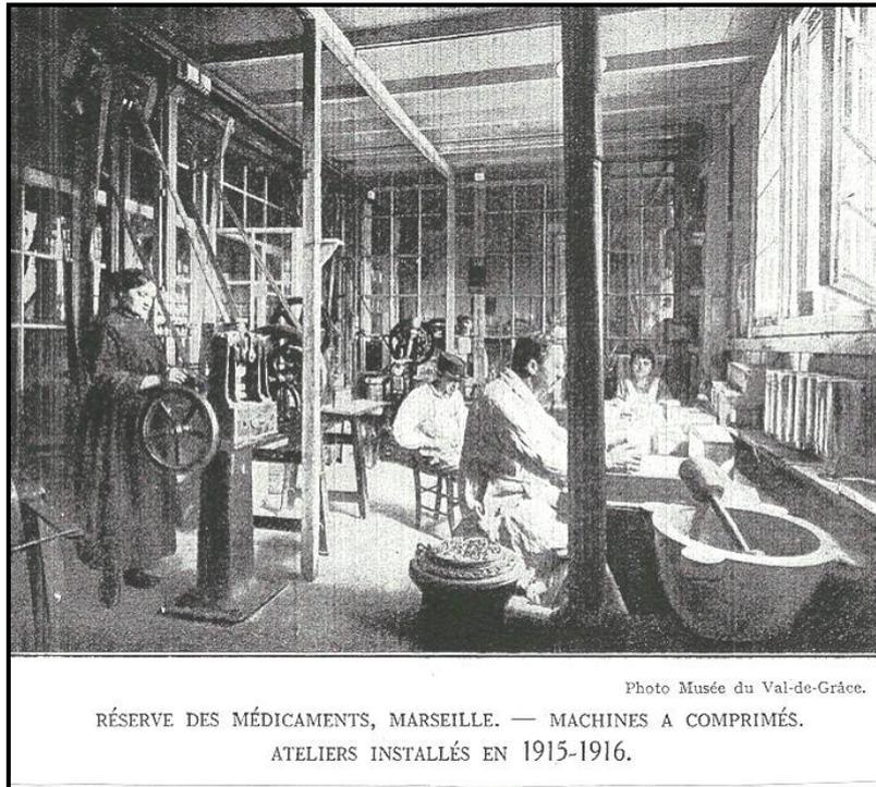
L'atelier est équipé d'une machine rotative fabriquée en Grande Bretagne par Allen et Handburry ,
