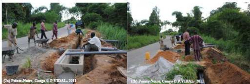
Photo 2 – Congo Télécom inspecte la bonne tenue des travaux entre le point d’atterrage du câble et la station terminale
