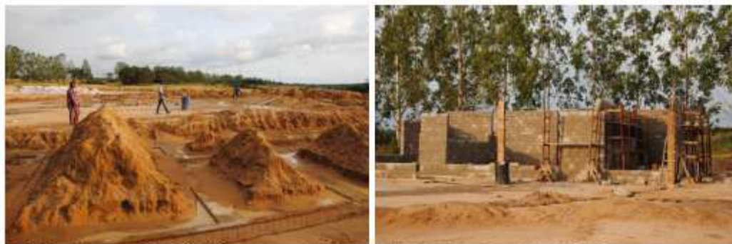
Photo 3 – Congo Télécom constate les ouvrages architecturaux de la station terminale
