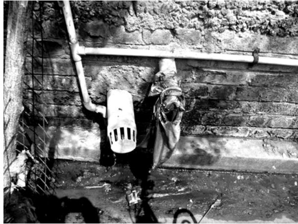
Guttering in Avvai Nagar
