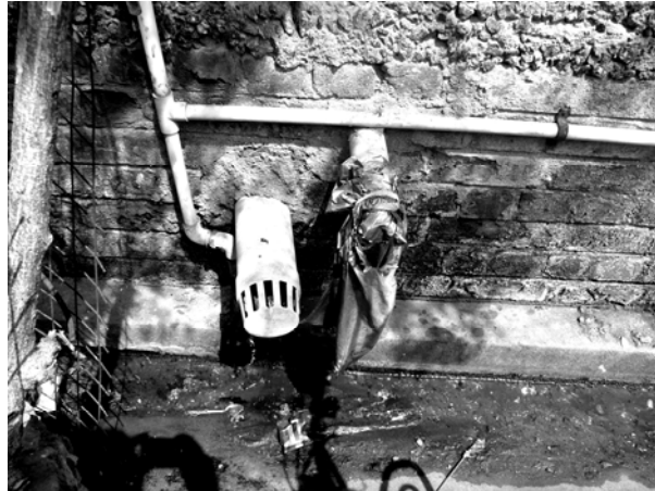
Guttering in Avvai Nagar
