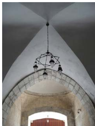
(Phot. 20) Belen. Caravansérail Sultan Süleyman, vestibule, coupôle et voûte d'arête de la grande salle. 2008.
