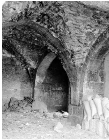
(Phot. 15) Han al-Bagrur , Jazirah (Turquie du sud-est), 1219-20, ayyubide, caravansérai à cour. Voûtes d'arête de la grande salle. (2008)
