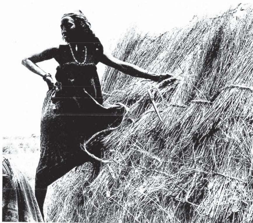
9. Construction de paillote
