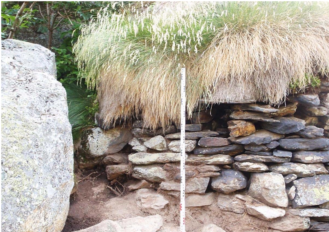
Figure 22 : M2, parement externe sud, trou d'aération au-dessus du F2.
