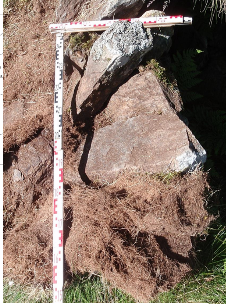
Figure 61 : Gispet couvrant les moellons du mur sud de l'abri
