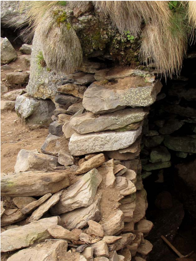
Figure 74 : Mur 1 détruit, côté sud-est de l'orri d'habitation principal. Photo Enrico Cangini.
