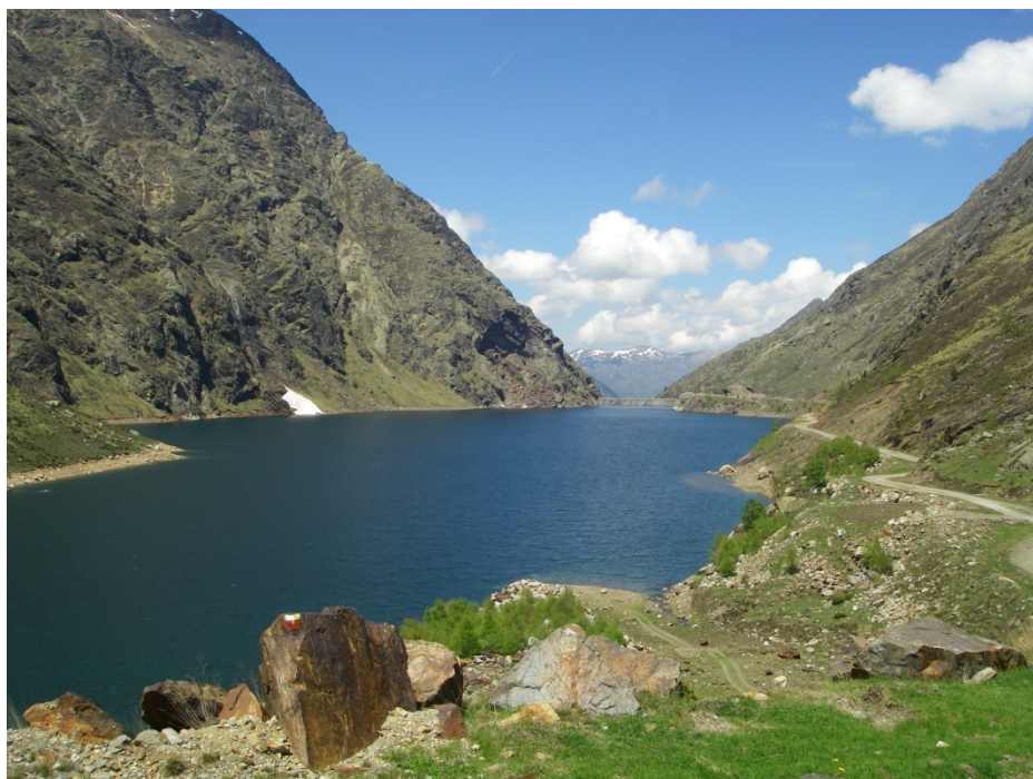
hydroélectriques de la Figure 2 : L'étang artificiel de Soulcem. vallée du Videssos
