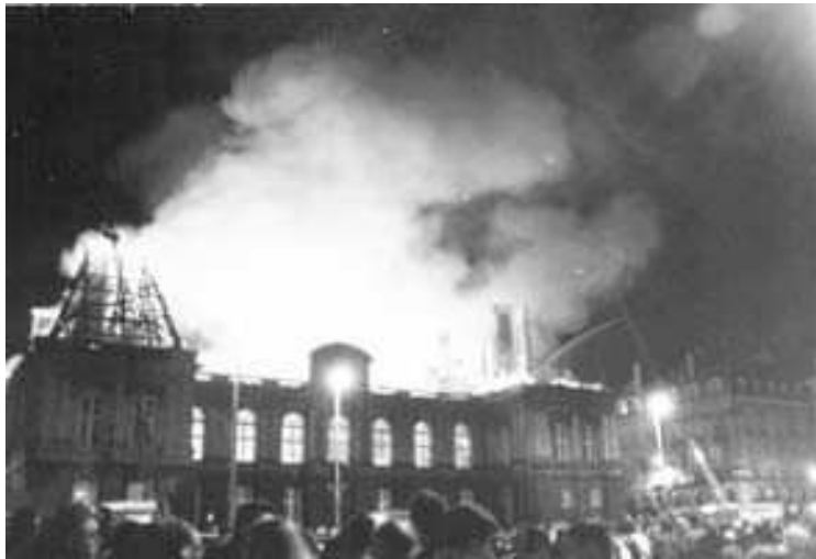
Figure 2 Incendie du Parlement de Bretagne dans la nuit du 4 février 1994 xxxiii
