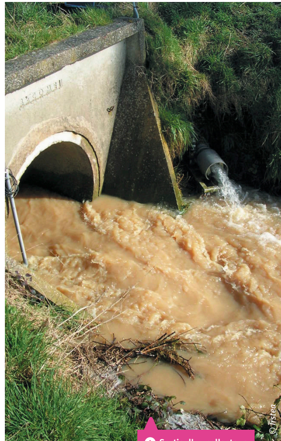
1 Sortie d'un collecteur enterré à Mélarchez.
