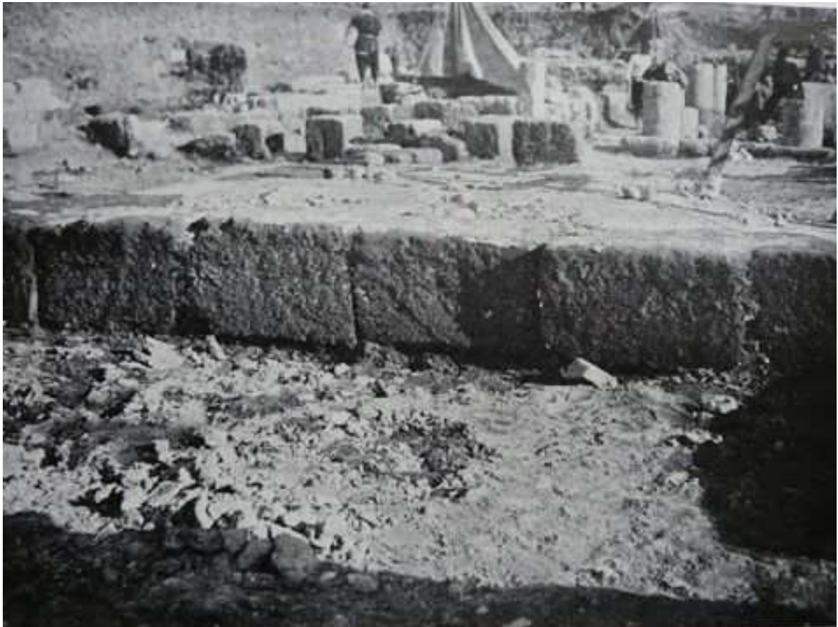
Doc. 6 : Maison à atrium, espace 130, le mur sud vu du nord
