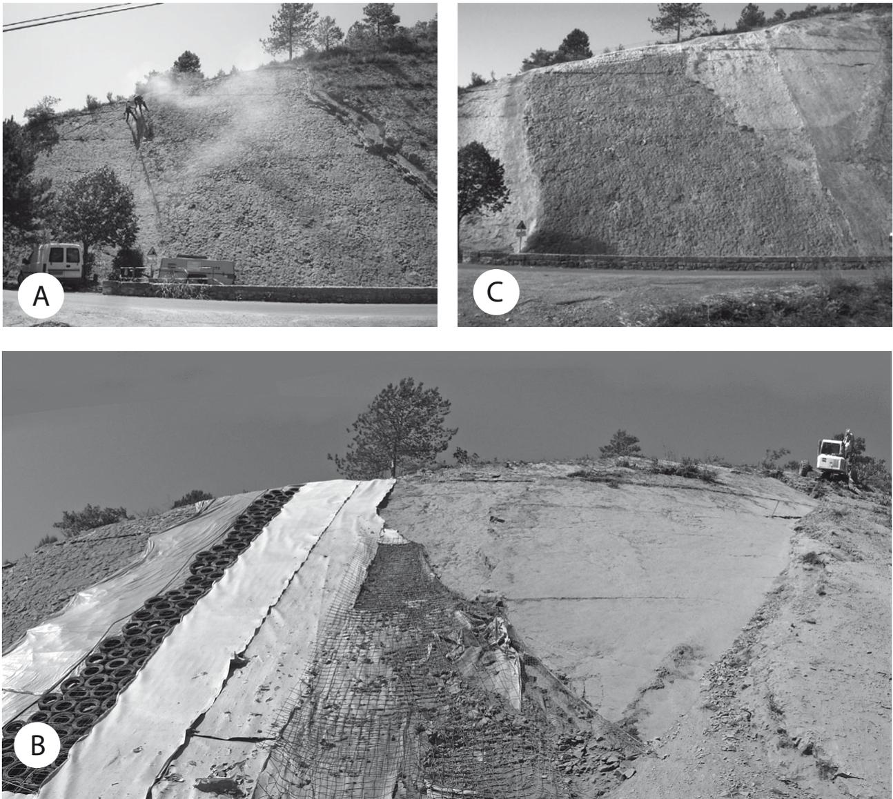
Fig. 5: Le chantier de sécurisation, de conservation et de mise en valeur de la «Dalle» en 2009. **A.** Le début du chantier en 2009 (Photo M. GUIOMAR). **B.** Vue panoramique du chantier (photo J. BOURIDEYS). Sur la gauche, des protections recouvrent les ammonites et sur la droite une pelle-araignée effectue le déroctage des surplombs. **C.** Le site de la «Dalle à ammonites» à l'issue du chantier de 2009.
