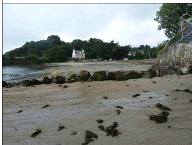
Photo n° 8 : ajout de blocs sur l'épi n° 1 au printemps 2012
