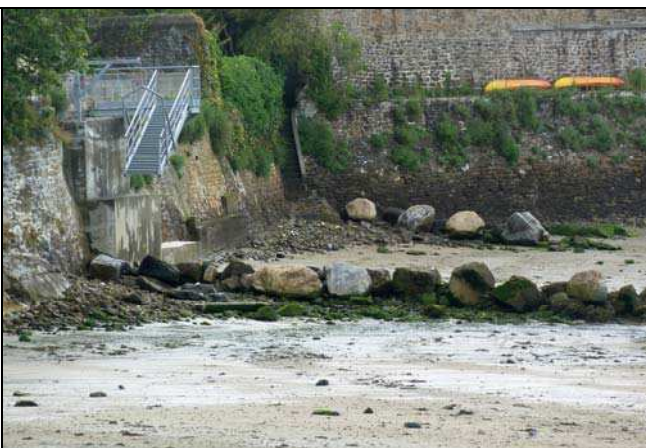
Photo n° 11: amélioration de la qualité paysagère par l'ajout de blocs au printemps 2012
