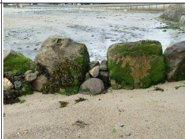
Photo n° 9 : colmatage des brèches entre les blocs rajoutés
