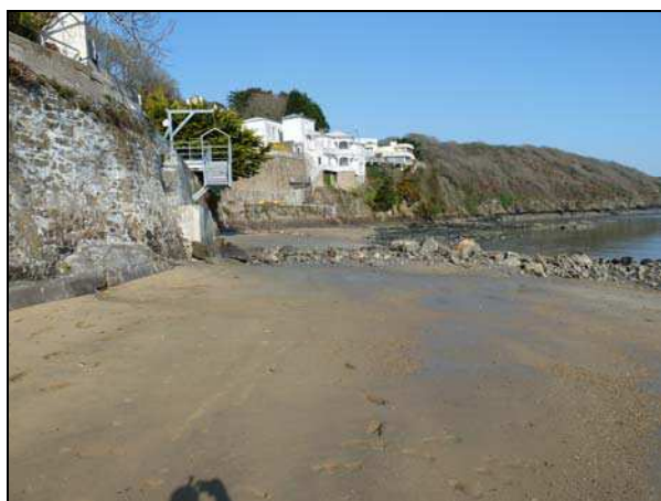
Photo n° 6 : L'épi n° 1 le 23 mars 2011 juste après rechargement. Noter les brèches, le fait qu'une partie de l'épi est posée sur du sable et donc appelé à se tasser.
