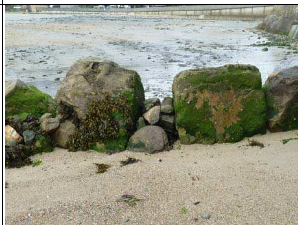
Photo n° 9 : colmatage des brèches entre les blocs rajoutés
