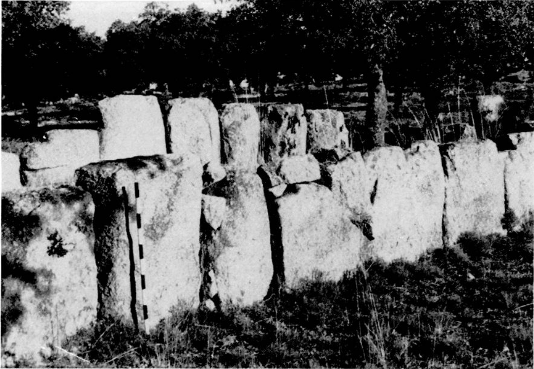
Fig. 6.— Parement d'orthostates de la troisième enceinte de La Mesa de Miranda (Chamartín, Ávila).
