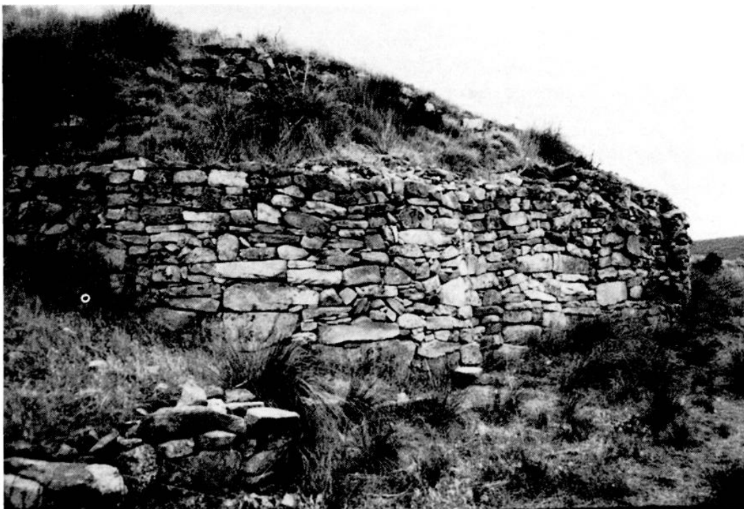
Fig. 8.— Bastion curviligne de l'enceinte supérieure de Las Cogotas (Cardeñosa, Ávila).
