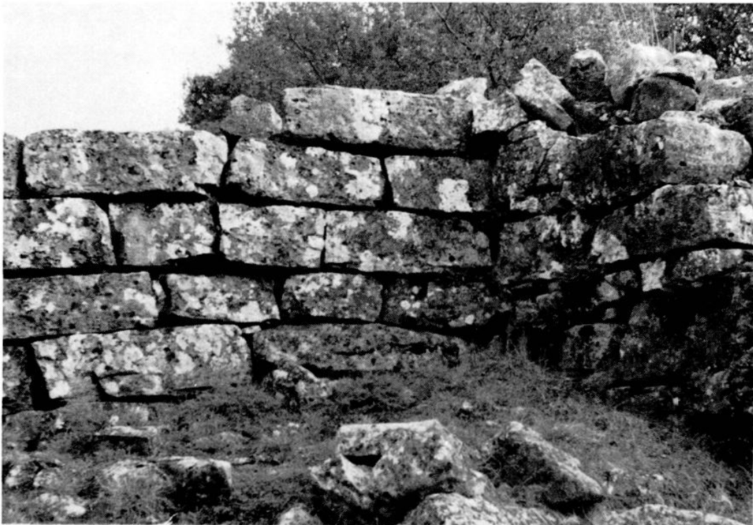
Fig. 9.— Décrochement du mur à crémaillère de Castilviejo de Guijosa (Guadalajara).
