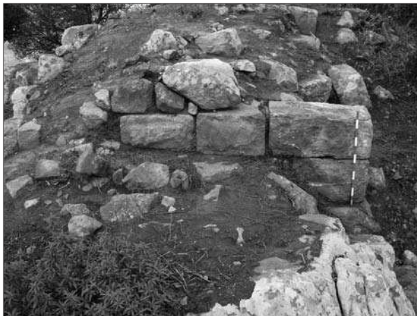
Fig. 7. — Tour sud-ouest, vue de la face sud.
