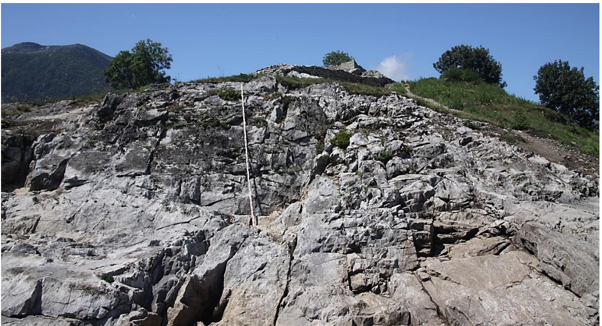
Fig : Vue générale vers le haut, retaille limite du caput castri ; à droite on aperçoit un angle de la rampe et l'encoche du poste de garde.
