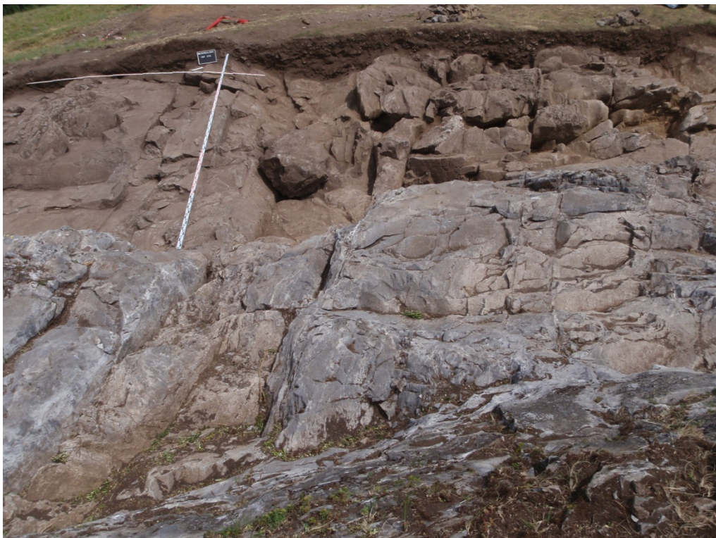
Fig : A l'ouest du poste de garde, en bas, le lapiaz est moins bien taillé : il a été nivelé et remblayé car il n'y avait pas assez de substrat terreux pour boucher les creux. Au-dessus, vous apercevez le haut de la retaille subverticale crantée
