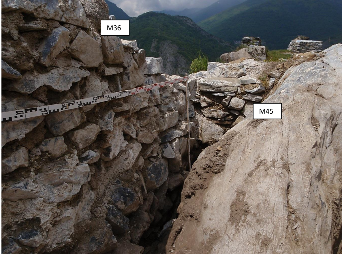
Fig : jonction du M45 avec le M 36 vue depuis le secteur PP, zone 6.
