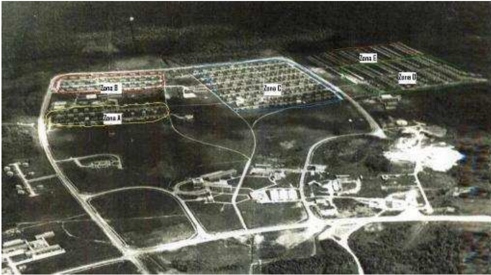
Vista aérea de Belmopan con sus 5 zonas residenciales, el sector administrativo, la colonia de los expatriados
