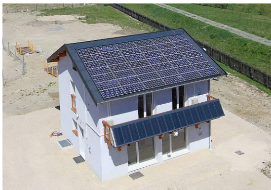
Figure 1. Vue de la façade sud de la maison I-DM servant de plateforme expérimentale dans le cadre du projet HOMES.
