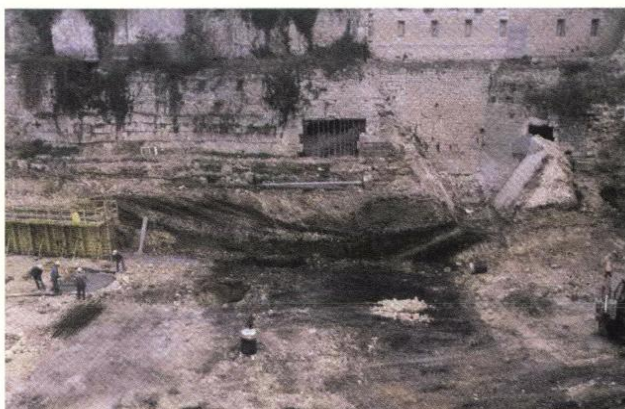
Fig. 6 : Fossé du haut de la rue Moyenne à Bourges lors des travaux d'aménagement de 1987 (cliché J. Troadec, Service archéologique de Bourges Plus).
