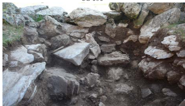
Face interne du mur MR 601
