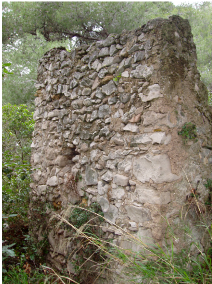
Document 18: Vue extérieure du bastidon dit "de 28 m 2 ". Photo du 23 décembre 2009. © 2009 Gilles OLIVE.
