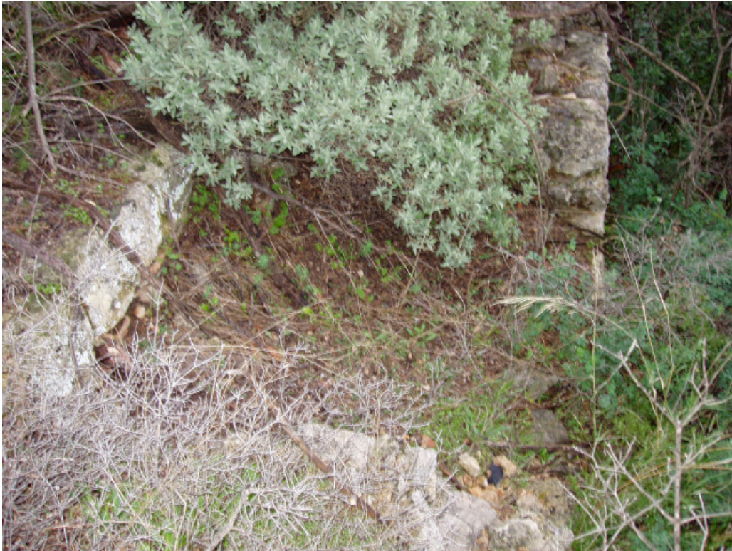
Document 25: Vue des escaliers au sud. Photo du 23 décembre 2009. © 2009 Gilles OLIVE.
