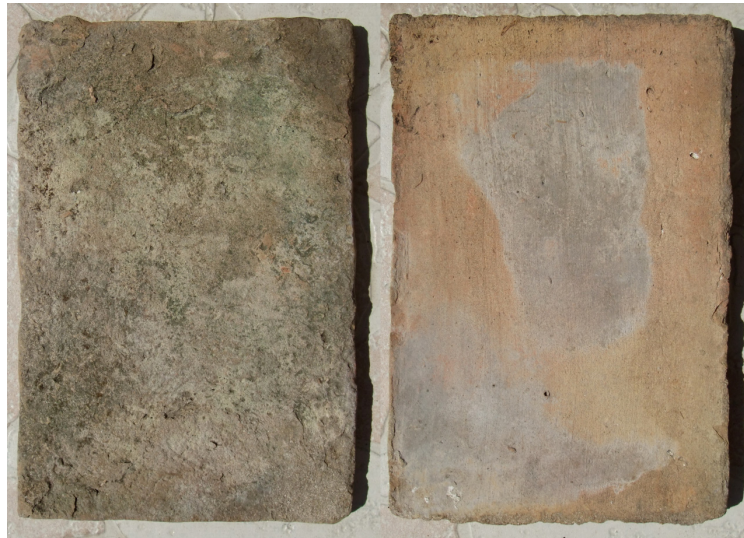
Document 19: Carreau de toiture du bastidon. Dimension: 24 x 16 x 1,5 cm. Collection privée Raineri.
