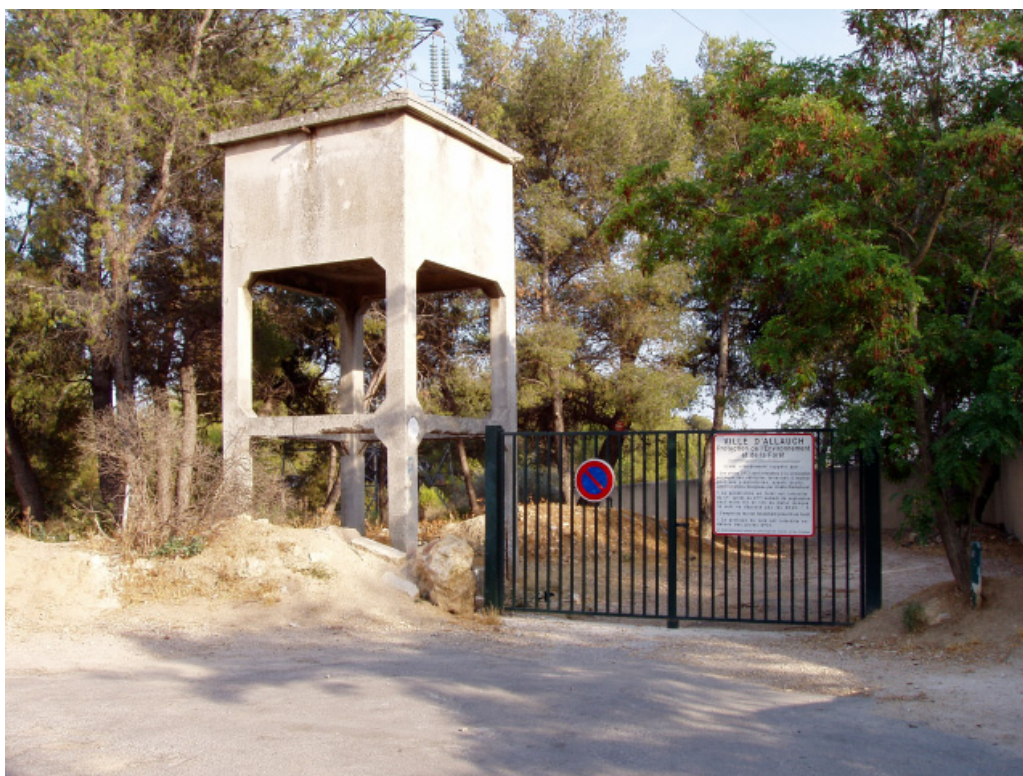
Document 27: Château d'eau en haut de la traverse de la Salette. Photo du 24 juillet 2006. © 2006 Gilles OLIVE.
