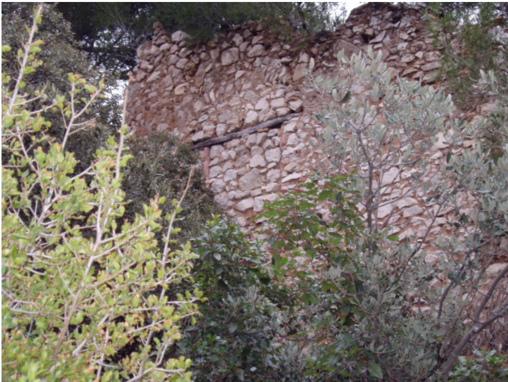
Document 24: Vue du mur "ouest", dit aussi mur à la fenêtre. Photo du 23 décembre 2009. © 2009 Gilles OLIVE.
