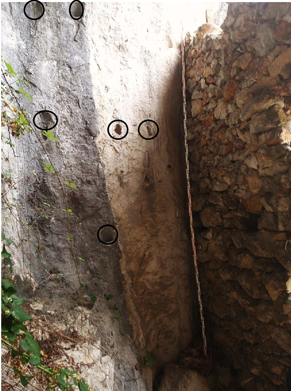
Paroi et mortaises à l'intérieur, côté nord, Photo Phil Bence.
