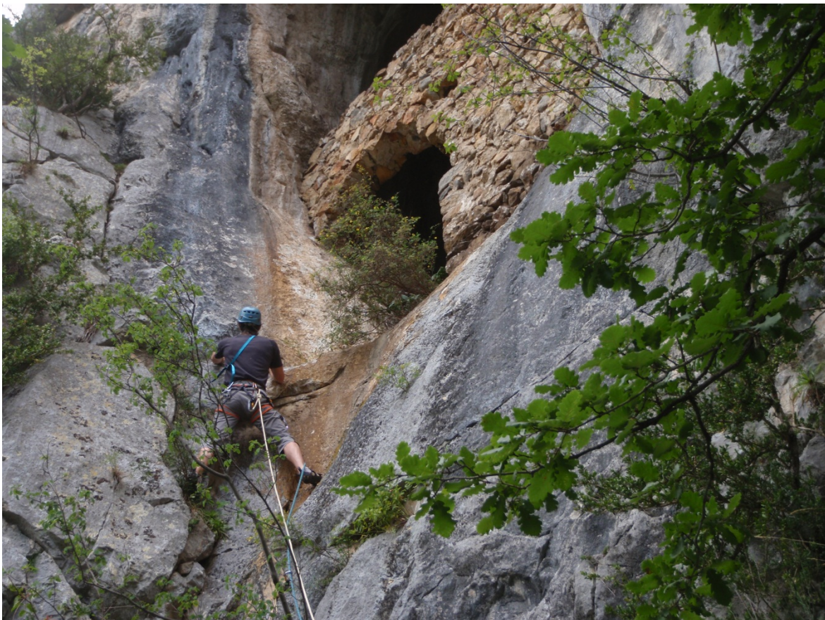
La spoulga vue du dernier pallier. La forme outrepassée de la porte est due à la perte des moellons au-dessus du piédroit. Noter l'absence de merlons/créneaux, le fait que la porte s'appuie sur la roche et le boulin (traversant) au-dessus et à droite de la porte. Photo F. Guillot.
