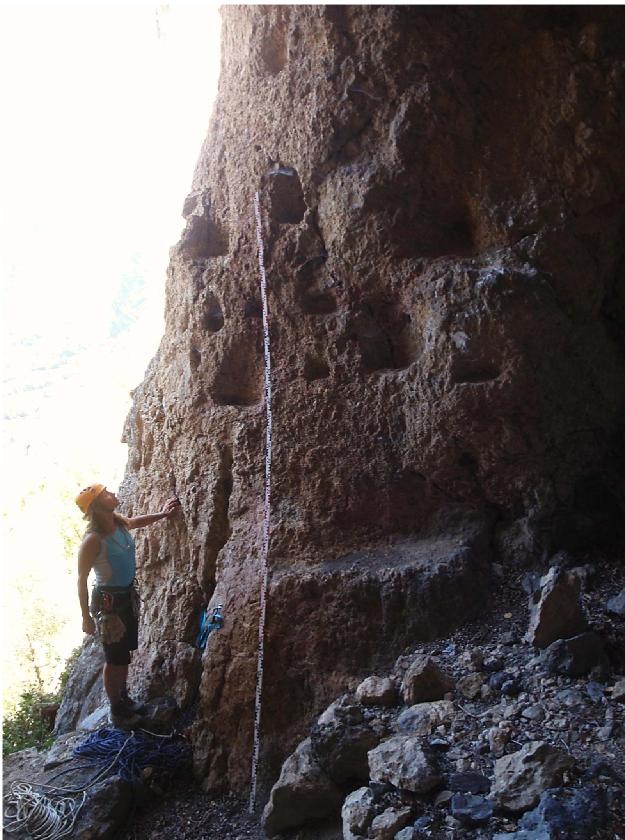
Même paroi (entrée face bord) que la photo précédente, mais vue différente. Le personnage est sur le mur maçonné et la mire mesure 4 m. A droite et en bas, on aperçoit la terrasse arrondie. Photo Phil Bence.
