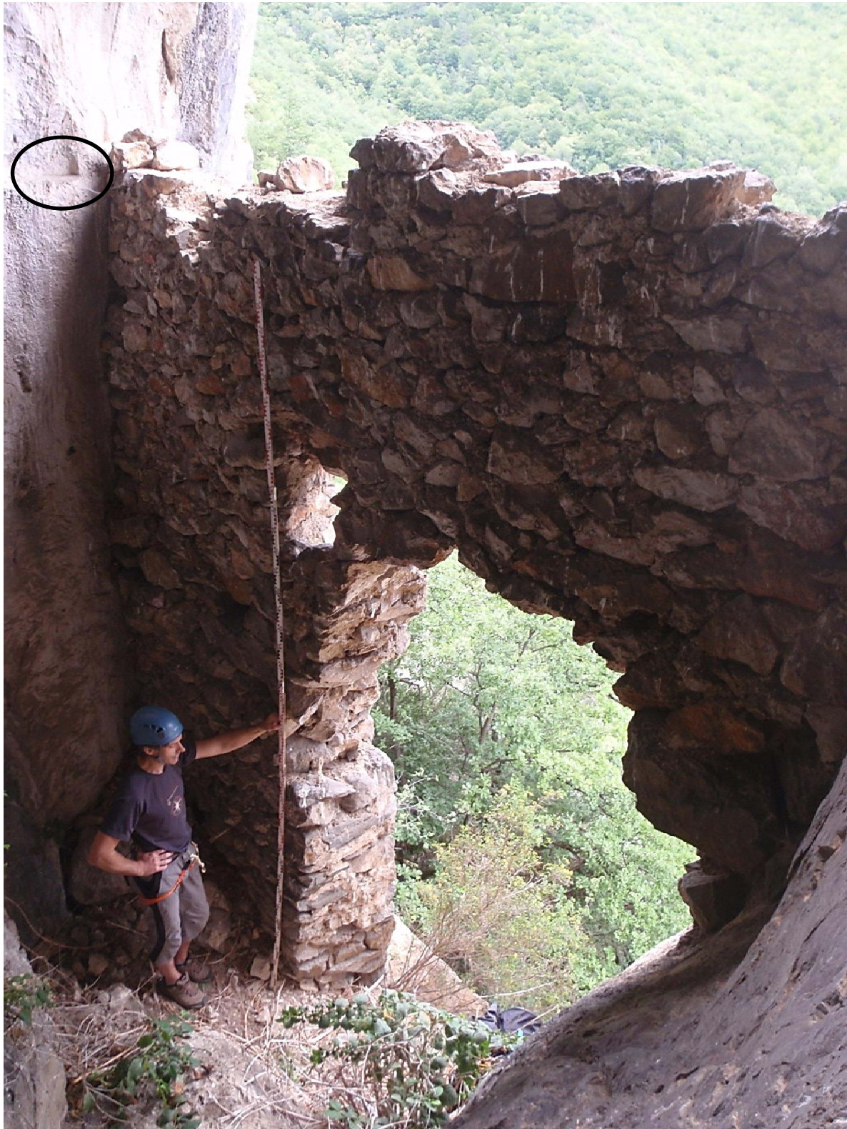
Face interne du mur qui barre le porche d'entrée. Photo F. Guillot.
