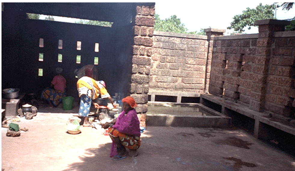
Cliché 20. Proximités paradoxales à l'hôpital de Bobo-Dioulasso : la cuisine à droite à côté des latrines ouvertes à gauche (cliché Ouattara, 2001)
