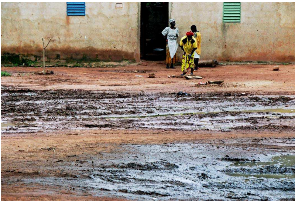
Cliché 24. Secteur 9 (Konsa). En hivernage, les eaux de pluie, les eaux usées domestiques et les excréta stagnent lamentablement. Elles se mélangent pour produire une fange immonde qui fait pourrir la base des habitations. Une jeune fille est sortie de sa cour pour couper du bois. (cliché Bouju, 2001).
