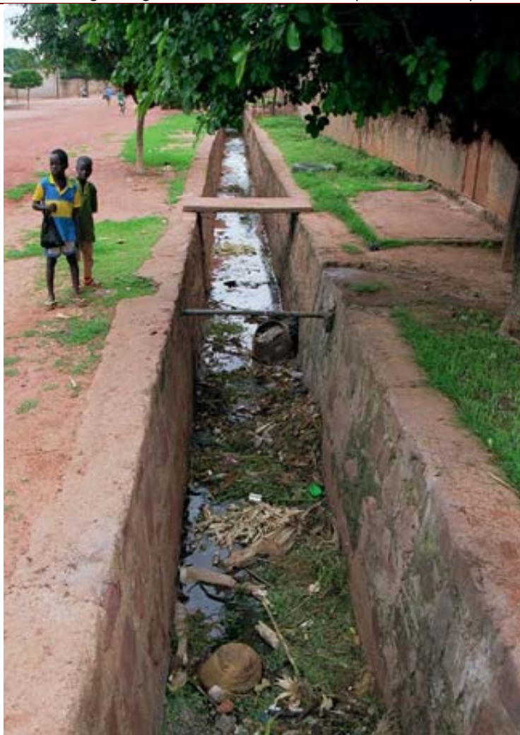
Cliché 14. Niénéta (secteur 12). Là où les canaux d'évacuation des eaux pluviales existent, ils sont bouchés, comme partout ailleurs dans la ville de Bobo-Dioulasso. (cliché Bouju, 2001)
