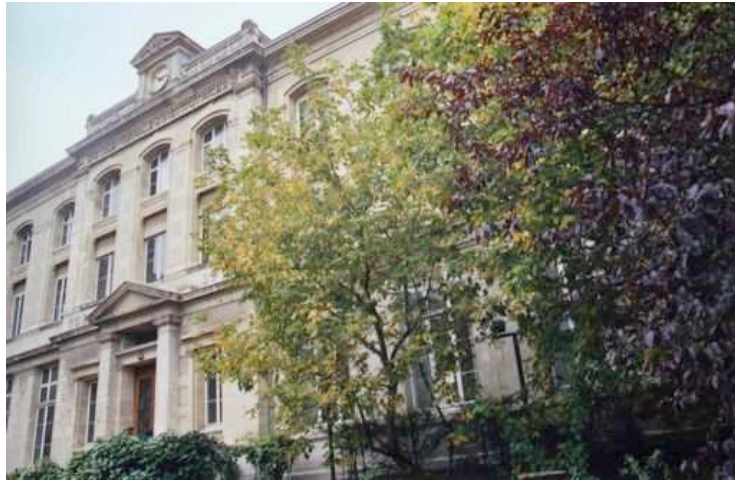
IUFM de Lyon, façade Tourette (2006) (Cliché F. Lignon)
