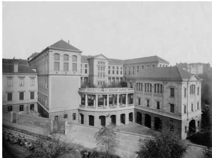
Rue de la Tourette Galerie sud-ouest et amphithéâtre 1890 (Archives départementales du Rhône, IT 1275)
