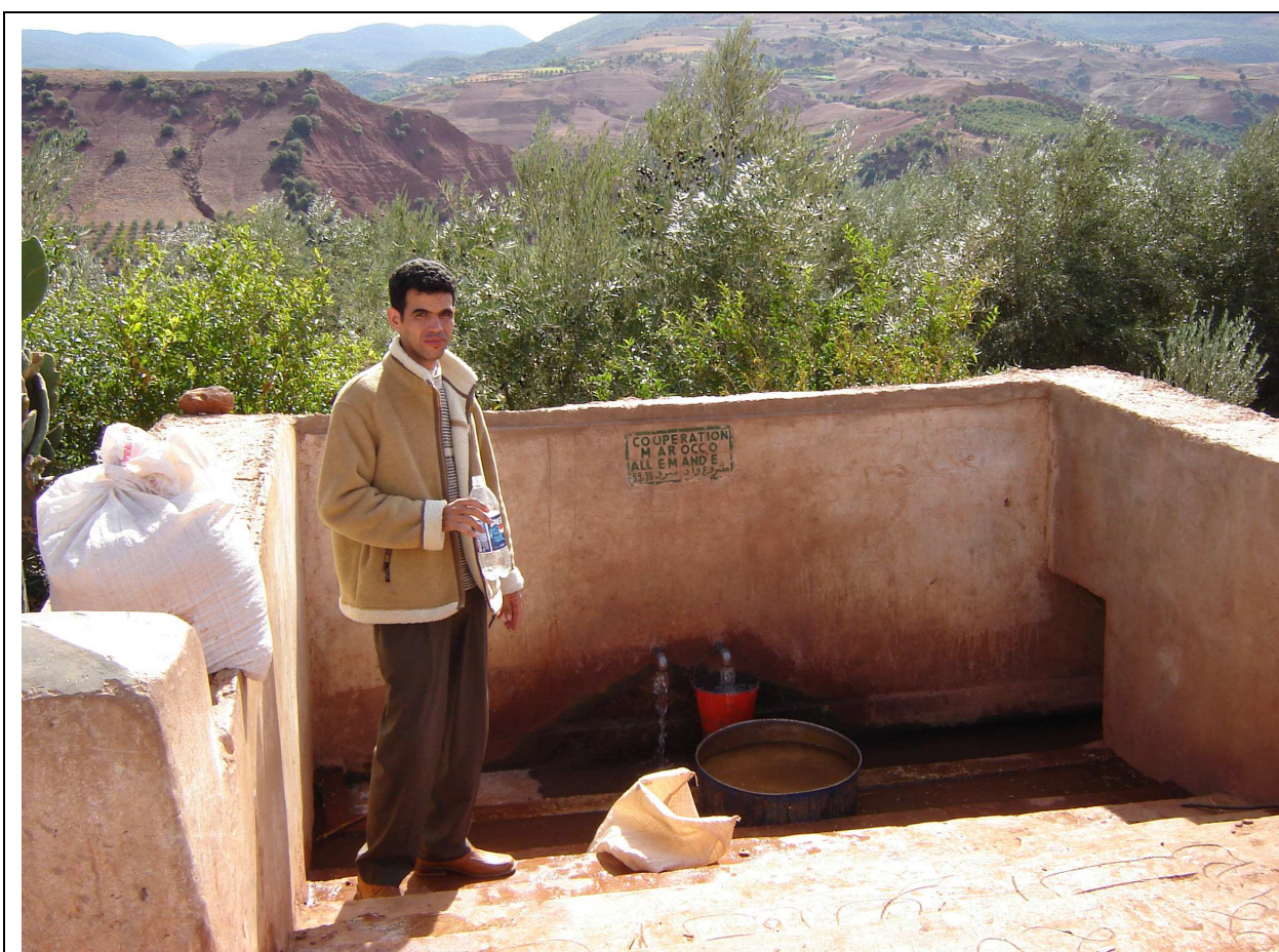
Photo 2 : Vue vers le Sud. Exemple d'un aménagement hydraulique du POS, situé à 9 km à l'est d'El Kebab. L'aménagement de la source (2 à 3 l/s) est conçu pour satisfaire plusieurs usages (borne-fontaine, lavoir, abreuvoir). Le surplus en eau est destiné à l'irrigation (cliché de l'auteur, 6 novembre 2005).
