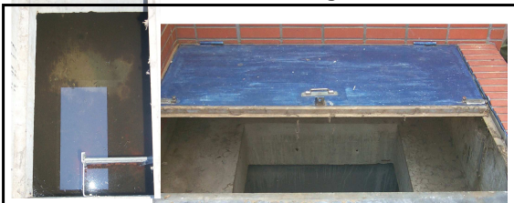
Bassin de décantation [en béton] situé en amont de la bâche de stockage enterrée
