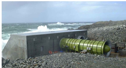
Figure 7.7. Dispositif à colonne oscillante LIMPET [MAC 04], courtesy of Wavegen.
