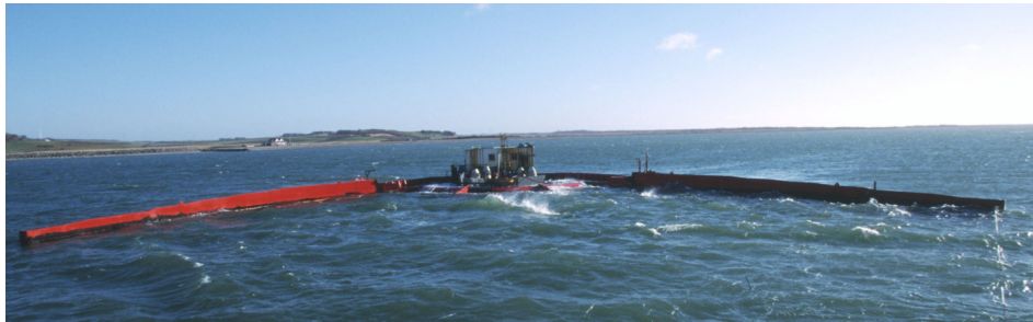
Figure 7.6. Photographie du Wave Dragon à échelle réduite (58 x 33 m), courtesy of Wave Dragon.
