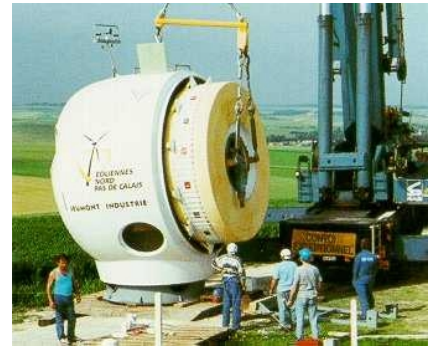
Levage de la nacelle
