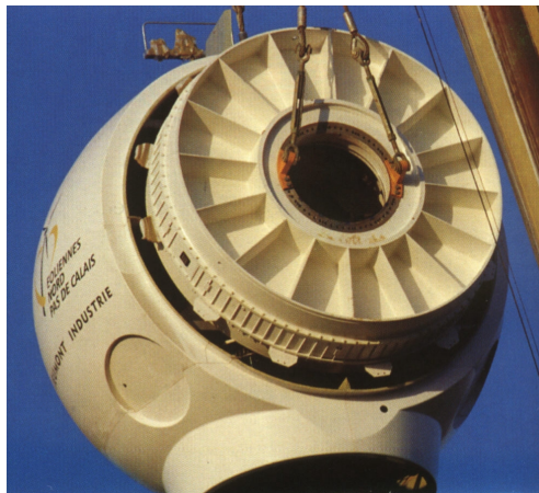
Levage de nacelle
