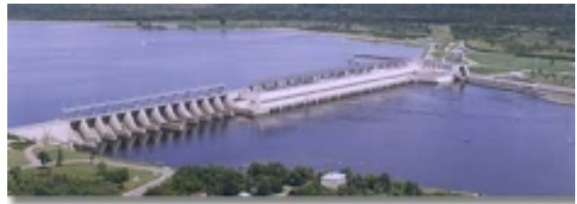
Figure 15 : Centrale au fil de l'eau de Carillon d'Hydroquébec 654 MW
