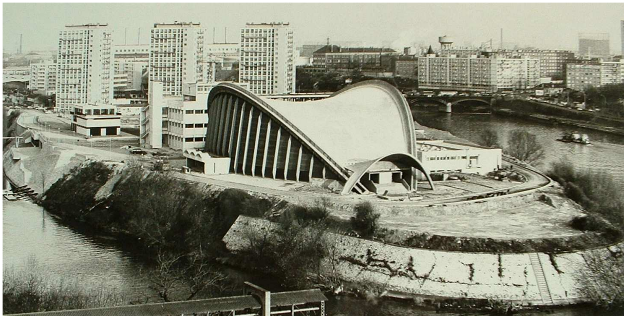
Fig. 1 : salle omnisports de Saint-Ouen sur l'Île-des-Vannes (Anatole Kopp, Pierre Chazanoff, Lucien Metrich, René Sarger et CETAC), 1962-1971. (© DAF/CAP centre d'archives). Les rives sont des arcs hyperboliques de béton armé.
