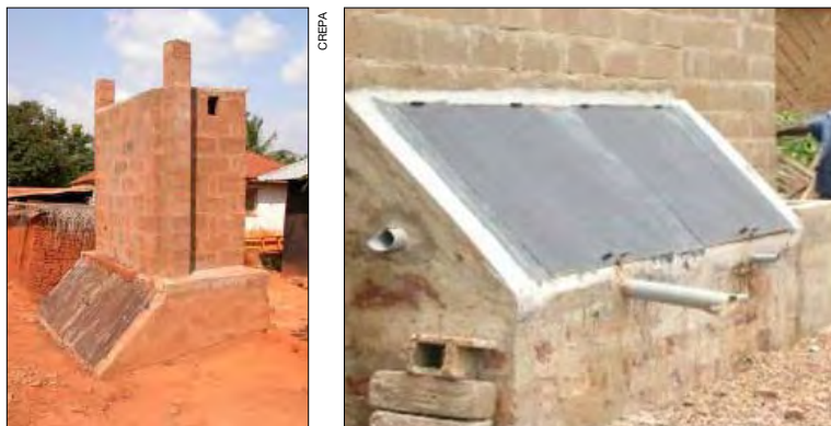
Figure 12 : lieu de déshydratation d'une toilette ECOSAN à double cuve
