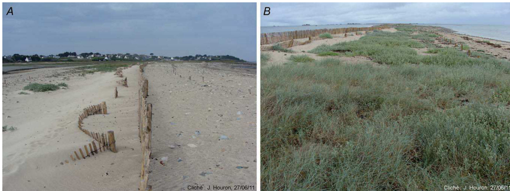
Figure 11 : Piégeage des transits éoliens par le réseau de ganivelles et reconstitution de la végétation dunaire dans la partie proximale du Sillon de Talbert.
