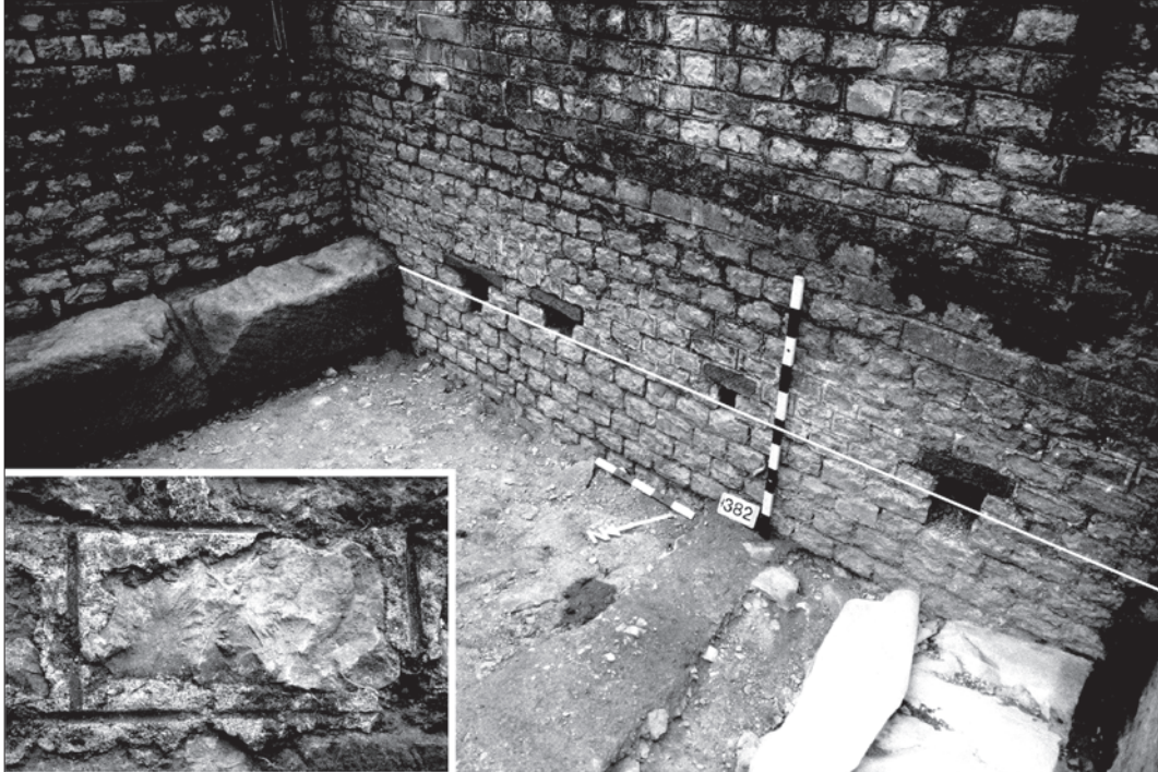
2. Mur en opus vittatum avec enduit pietra rasa et joints rehaussés de rouge sur le mur périphérique du théâtre le plus récent d'Augusta Raurica, vers 180 apr.J.-C. Ce traitement de paroi ne se trouve qu'au-dessus du niveau de sol (désigné par une ligne) et remplace techniquement et esthétiquement un enduit couvrant l'ensemble du mur (l. Horisberger-Matter, Augusta Raurica).
