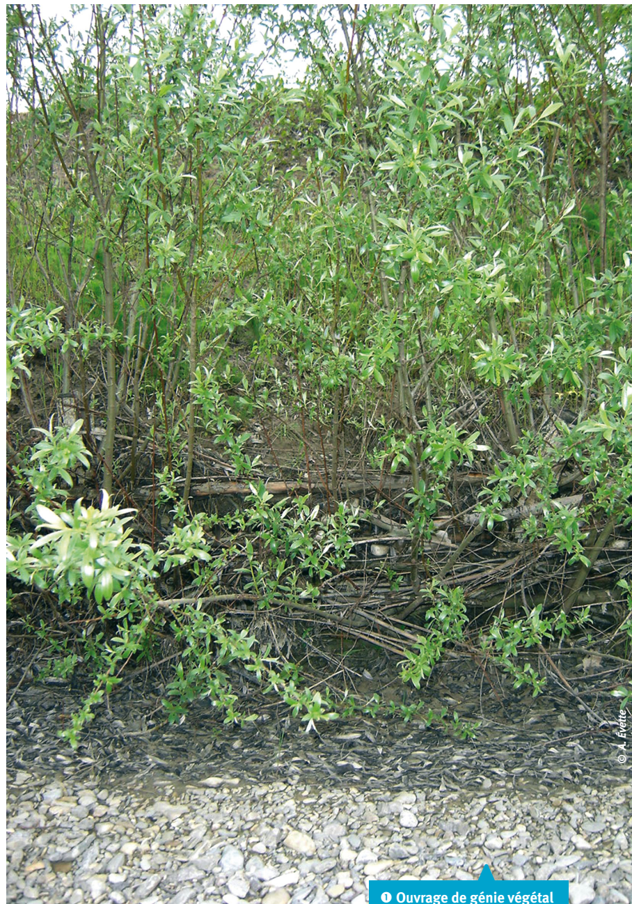
1 Ouvrage de génie végétal en berge de rivière.
