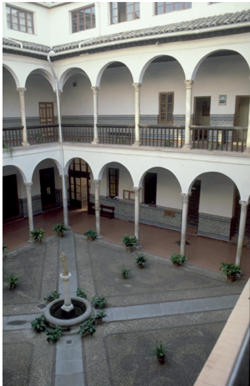
Figura 11 - Palacio de Suer Téllez de Meneses: Patio regularizador contemporáneo.
