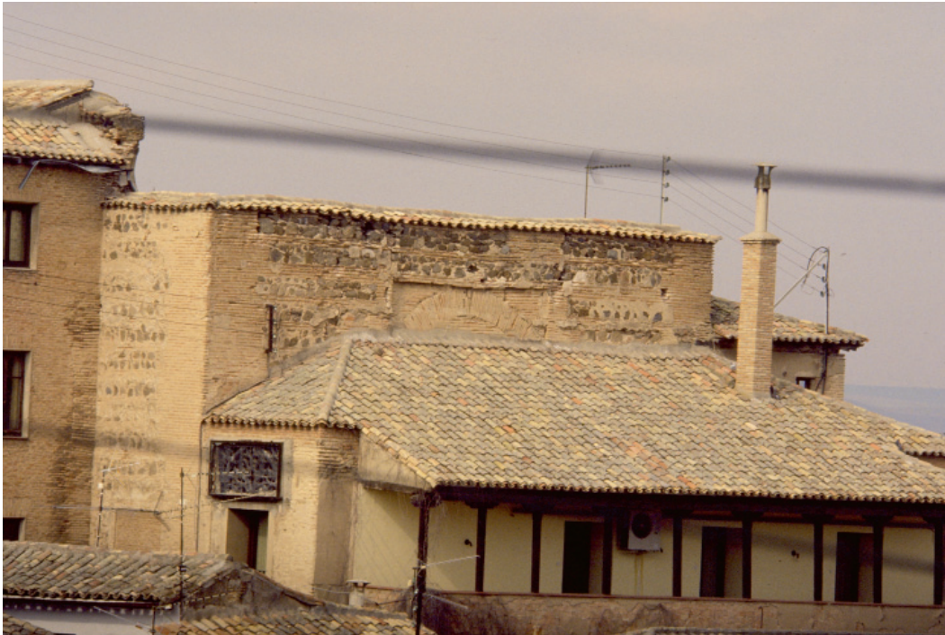
Figura 19 - Palacio de Malpica: fachada, la exterior hacia el este. restos de alfiz y arco
