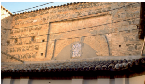
Figura 20 - Palacio de Malpica: fachada la interior hacia el este. restos de alfiz y arco
