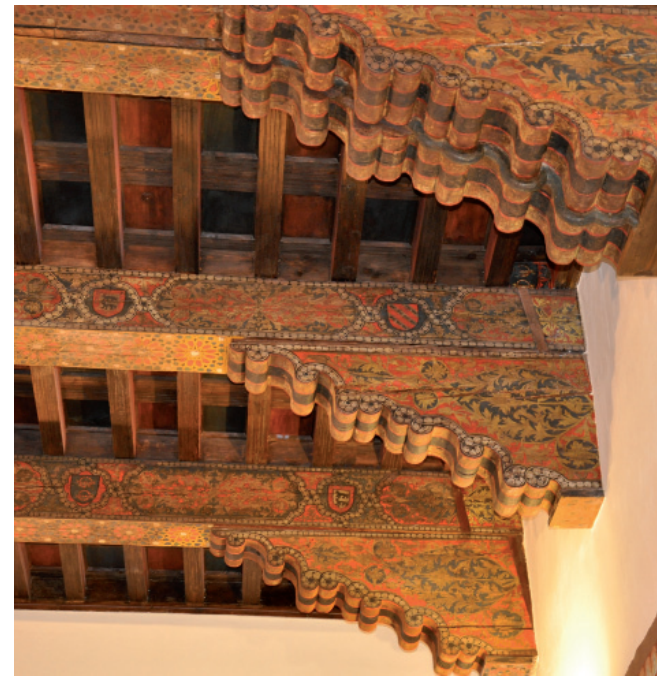
Figura 16- Palacio de Fuensalida: techumbre de la sala cuadrada
