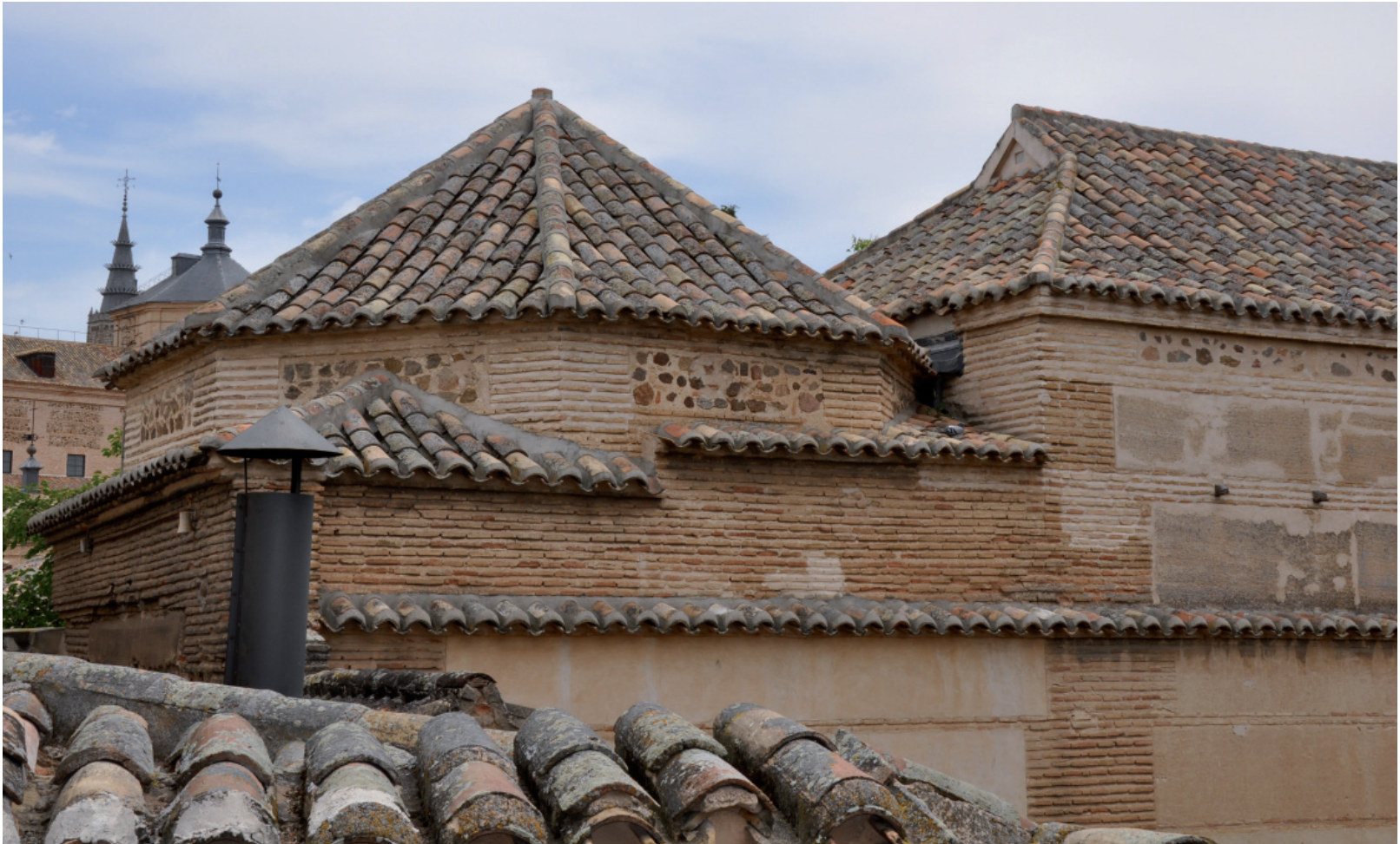
Figura 25 - El Taller del Moro: fachada interior hacia el sur.
