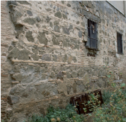
Figura 6 - Palacio de don Juan Manuel (monasterio de Santo Domingo el Antiguo): aparejo de los sótanos en los muros de la "quadra".
